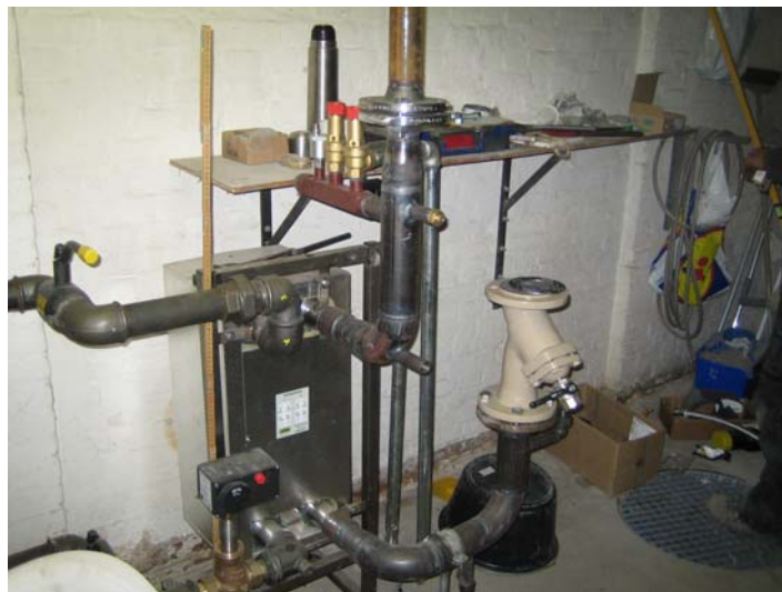
Det nye anlæg. Den firkantede kasse er den nye varmeveksler, der forsyner hele ejendommen med varme
